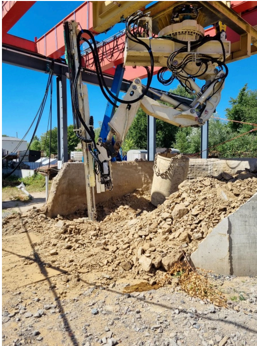
Abbildung 33: Variables Arbeitsgerät am Schachtbagger – hier eine Bohrlafette
