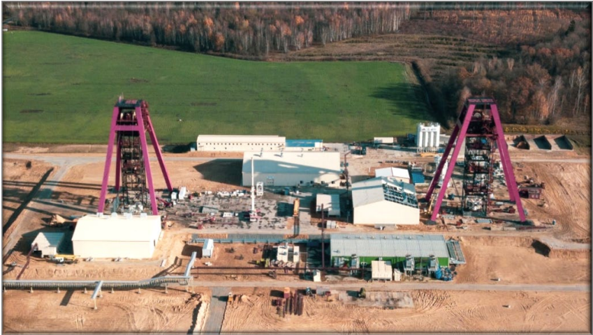
Abbildung 1: Schachtbaustelle der Schächte in Nezhinskiy
