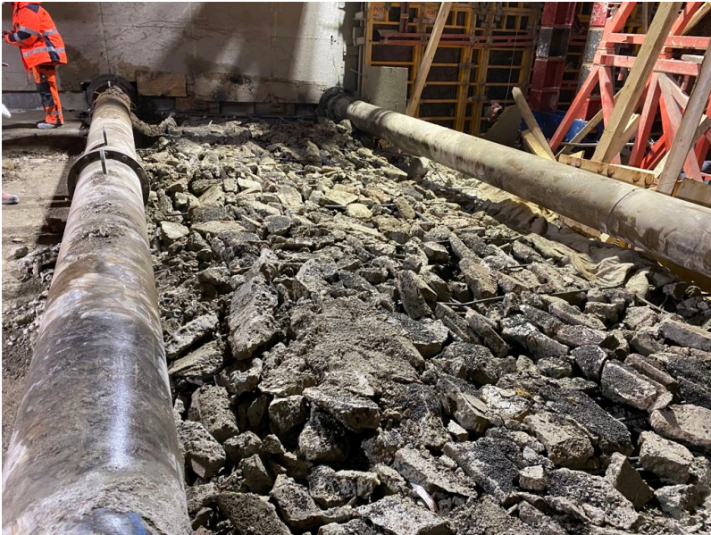
Abbildung 7: Sprengergebnis im Sprengfeld zwischen den Steifen
