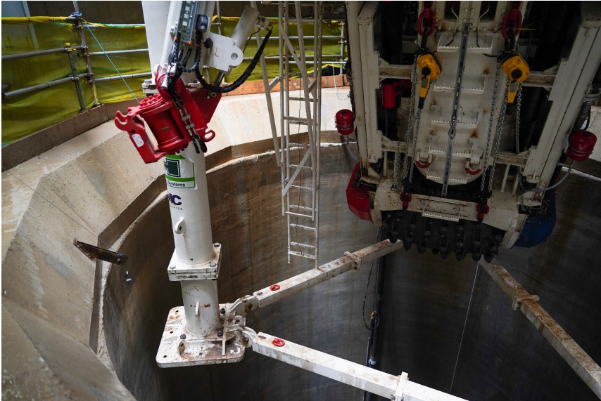
Abbildung 25: SBR-Modul mit dem Schneidausleger taucht in den Vorschacht ein
