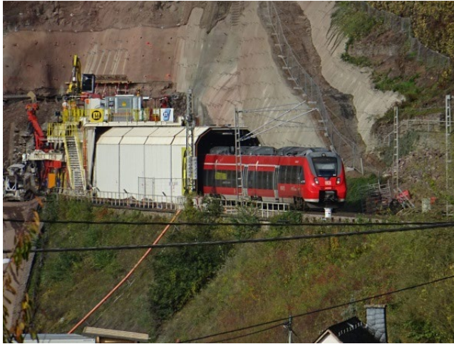
Abbildung 1: Baustelle am Südportal
