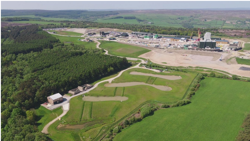
Abbildung 19: Gesamtaufnahme des Minengeländes
