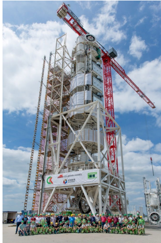
Abbildung 2: SBR im aufgebaut im Werk der Fa. Herrenknecht
