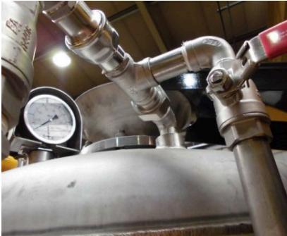
Abbildung 6: PAUS Ober- (links) und Unterluftsystem (rechts)
