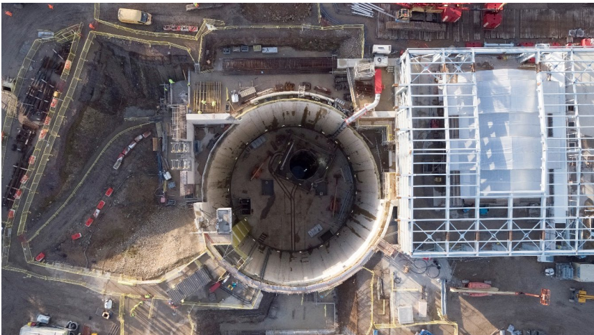
Abbildung 21: Blick in den Startschacht mit Vorschacht
