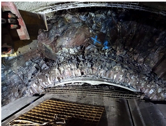
Abbildung 6: Vortrieb mittels Bohrhammer
