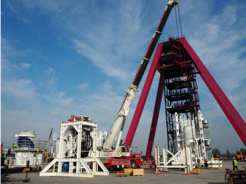
Abbildung 7: Einheben der SBR-Module
