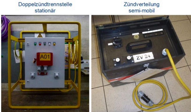
Abbildung 5: Zündeinrichtungen für das Fernzünden aus dem elektrischen Netz
