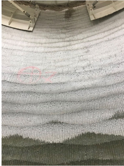
Abbildung 10: Schachtwand im Zustand nach dem Schnitt im Gefrierschacht
