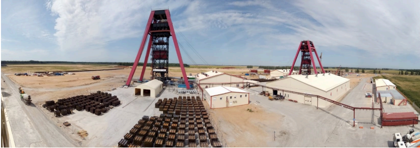
Abbildung 14: Panorama über die Baustelle
