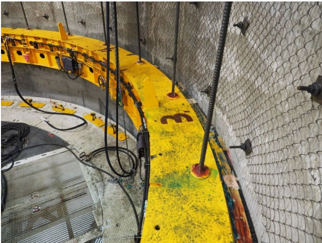
Abbildung 9: Patentierter, hydraulischer Tragring
